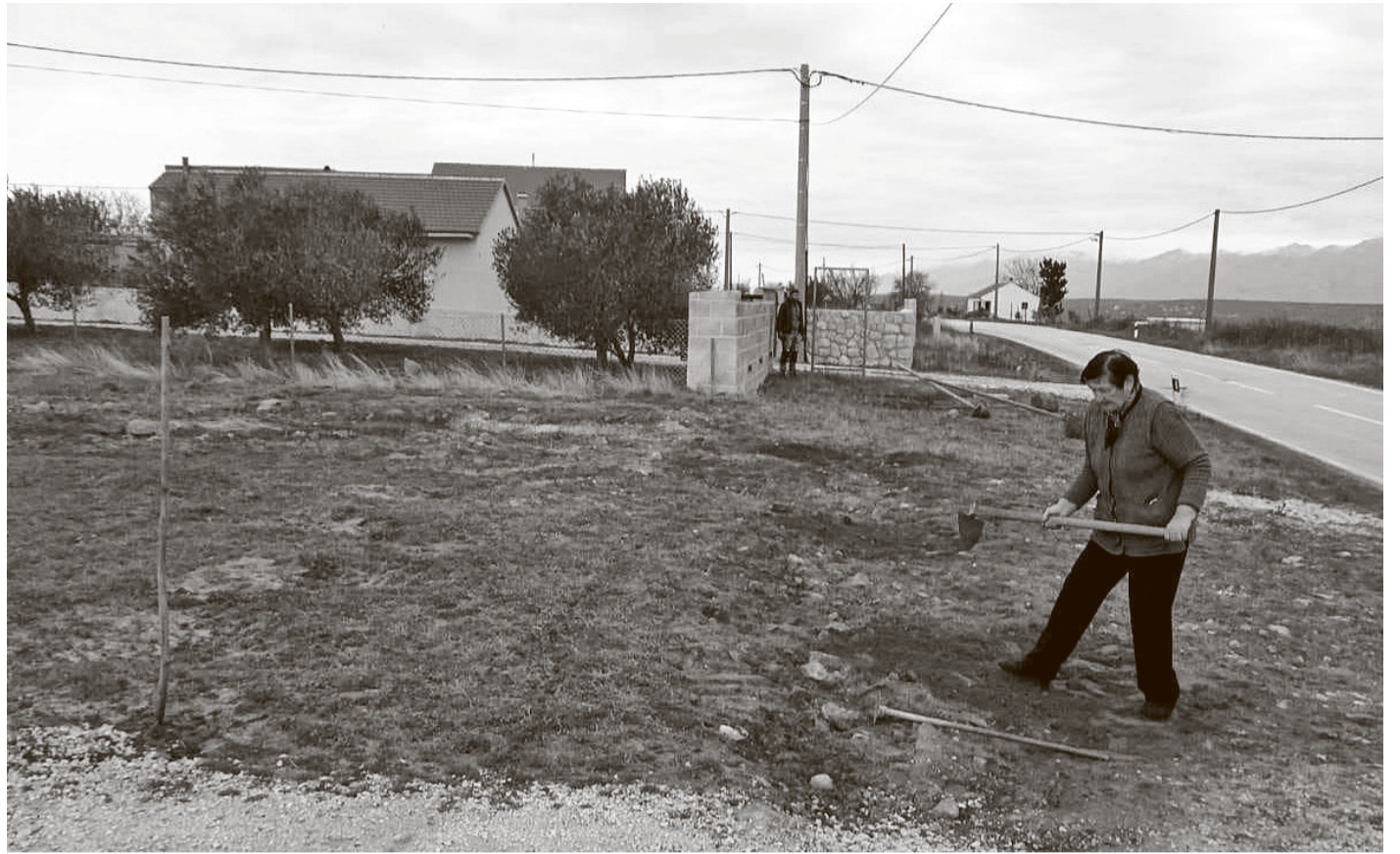
Stevanija Kalapać zatrpava rupe od betonskih stupova, 16. veljače 2025.
