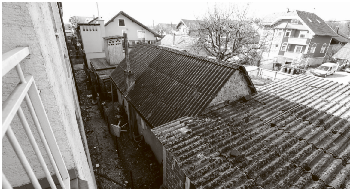
Насеље на рубу града – Нови Петрушевец (Фото: Јурица Галоић/PIXSELL)
